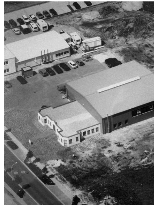
Erster Neubau in Achim mit 1.000 m 2 Hallen- und 300 m 2 Bürofläche.
